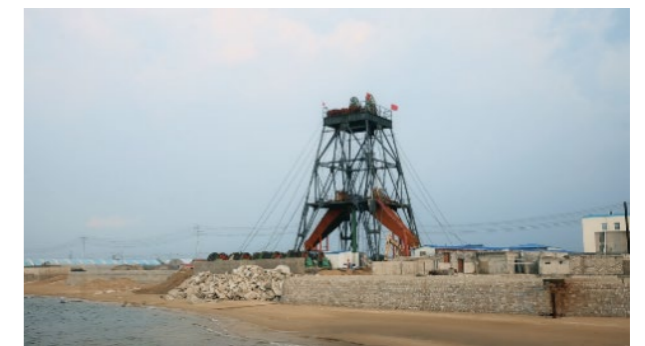
招金瑞海项目：国内已竣工最深竖井之一
