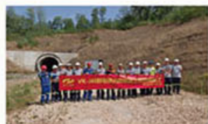
VK-JM 矿新旧排洪坝贯通工程、排洪坝封堵工程
